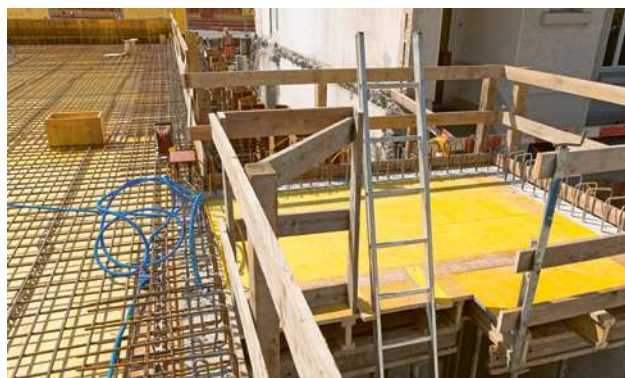
32 Passaggio messo in sicurezza: la scala sporge di almeno un metro dal bordo del piano superiore
