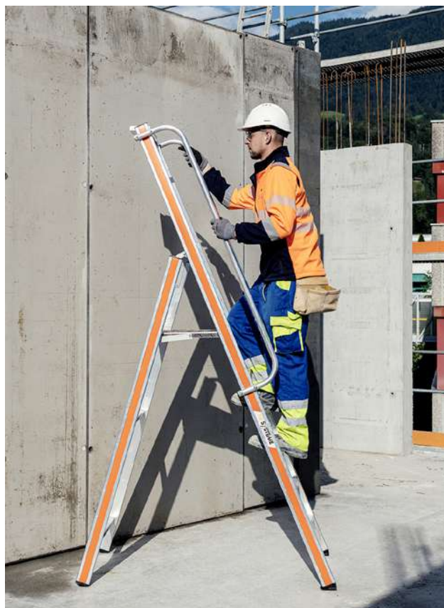
27 Come salire correttamente su una scala leggera con piattaforma
