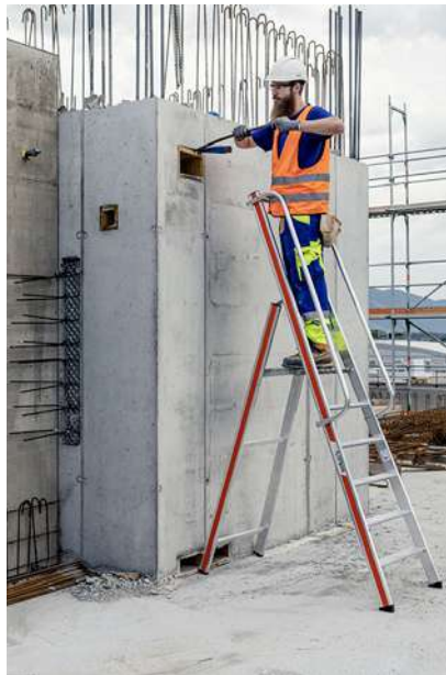
20 Lavori su una parete di calcestruzzo
