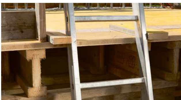
41 Guide laterali per l'estremità superiore della scala
