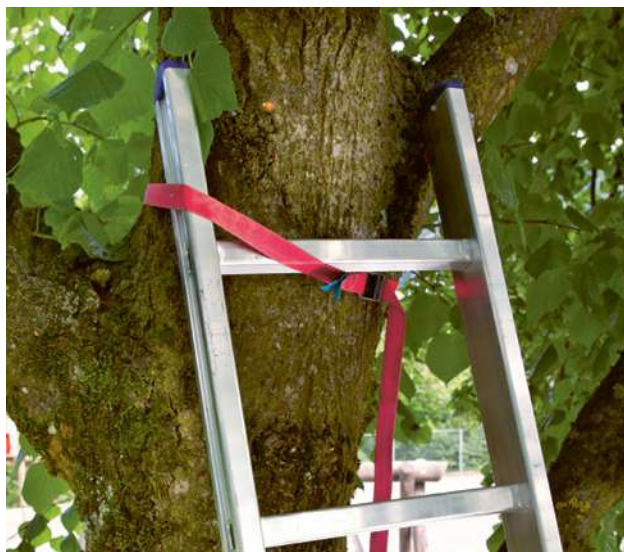
44 Fissaggio con cinghie
