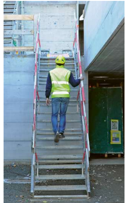
9 Scala a gradini da cantiere
