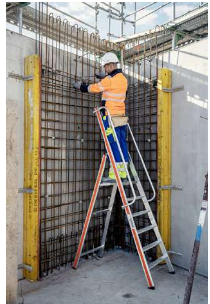
21 Posa del ferro d'armatura di un parete
