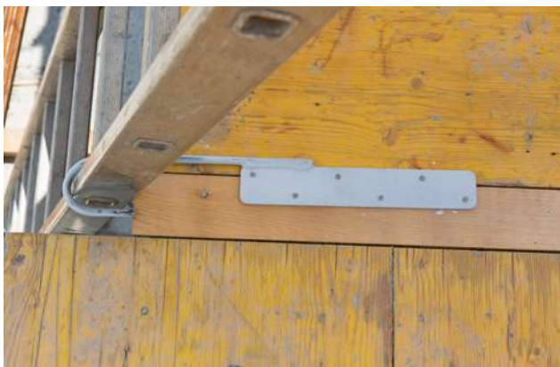
45 Fissaggio dell'estremità superiore della scala con un gancio
