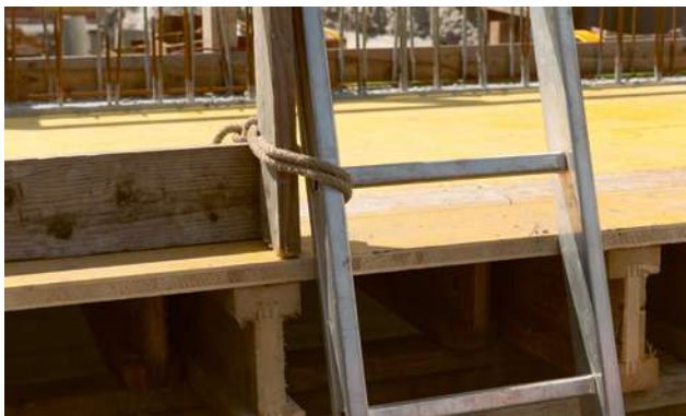
43 Fissaggio con fune
