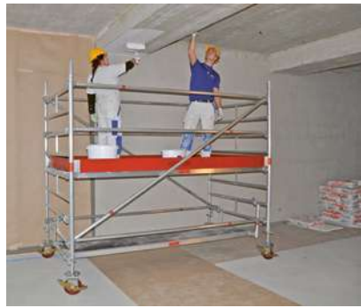
8 Ponteggio mobile su ruote
