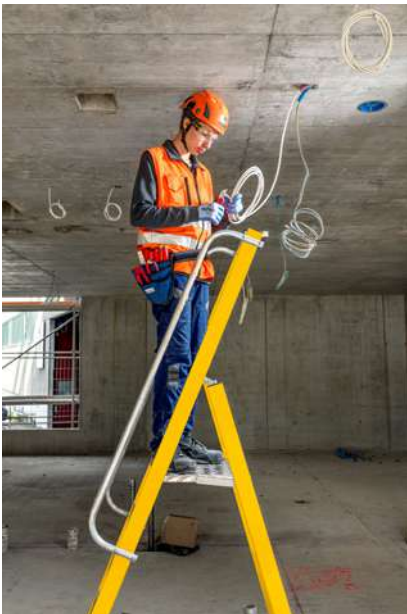
19 Lavori di tecnica della costruzione
