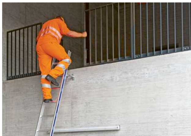
33 Dispositivo per tenersi, parapetto in prossimità dell'apertura nel vuoto ed estremità superiore della scala messa in sicurezza
