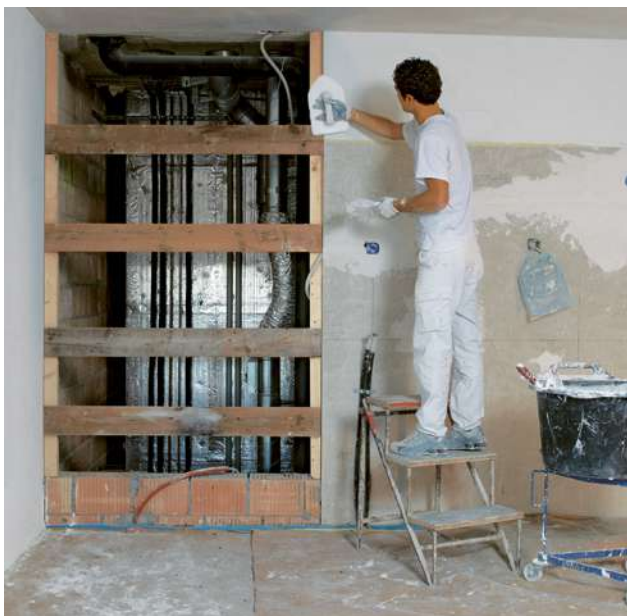
16 Gessatore al lavoro in prossimità di un'apertura nella parete
