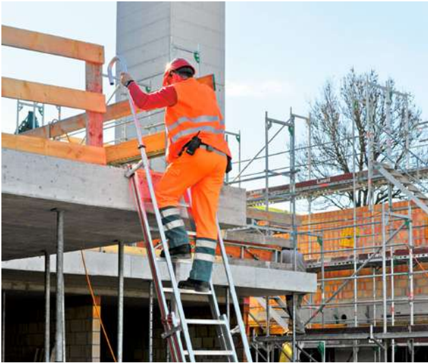
34 Montanti allungati per un passaggio sicuro
